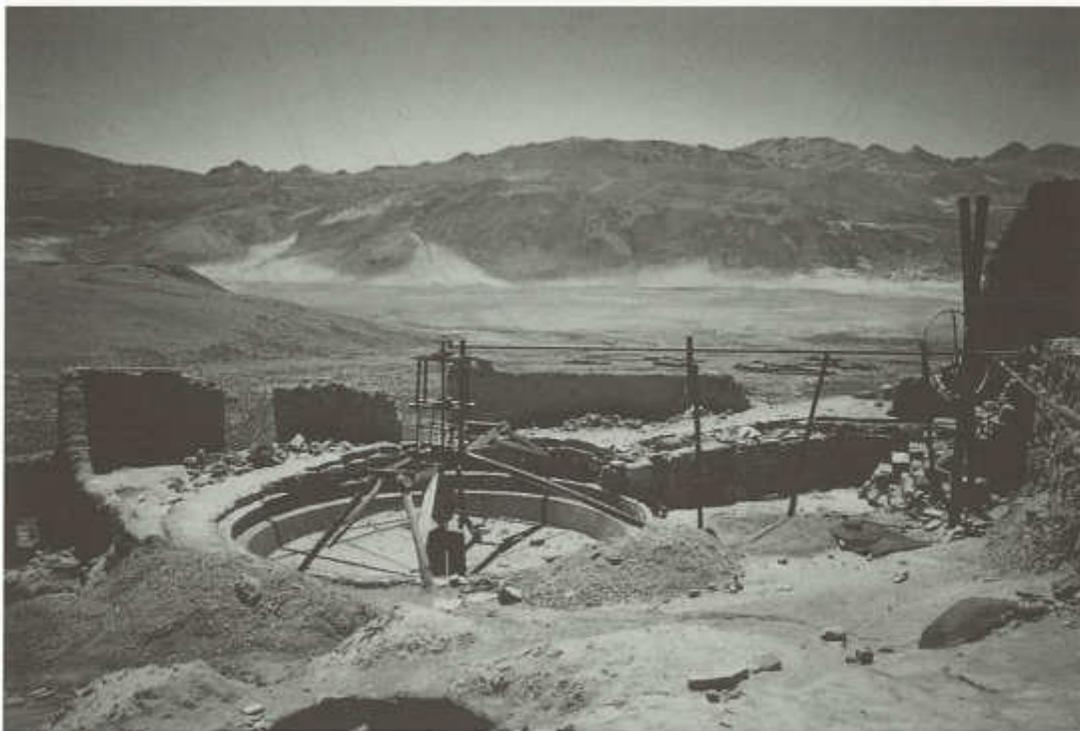
Restos de un buddle mecanizado de aprox. 8 m de diámetro. Esta instalación servía antes para la concentración de grano de tamaño finísimo de minerales de plomo y plata, cerca a Potosí, Bolivia.
