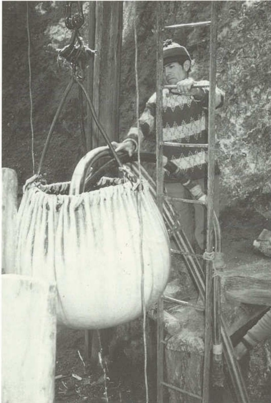
Desagüe mediante extracción con botas de aro. Vaciado de la bota en el enganche superior por medio de una manguera de absorción. Mina de antimonio Santiago/Oploca, Potosí, Bolivia.
