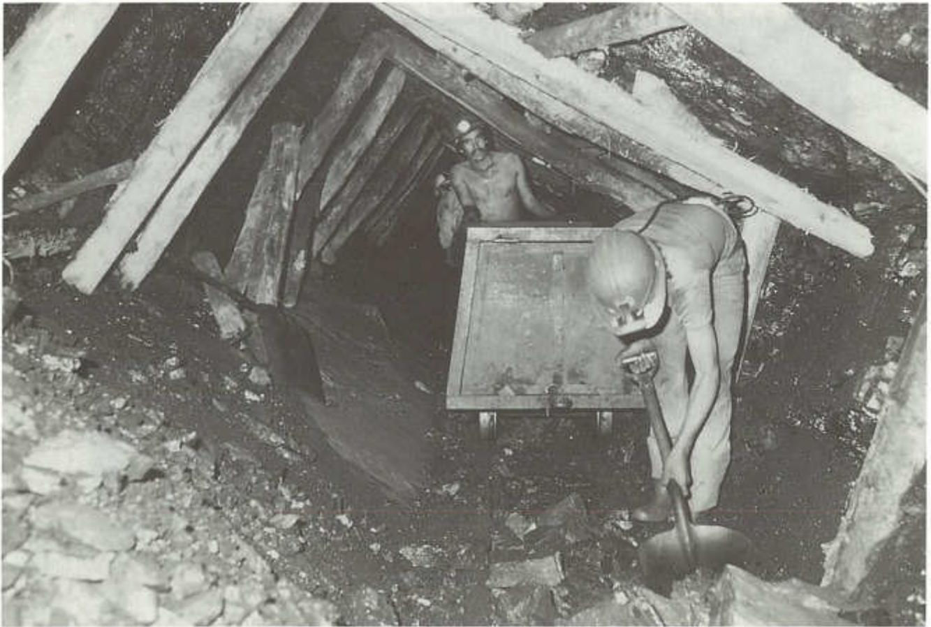
Carga manual de un vagón sobre rieles. La galería está fortificada con entibación transversal de madera con dos estemples. Minería del carbón en la región Checua, Cundinamarca, Colombia.
