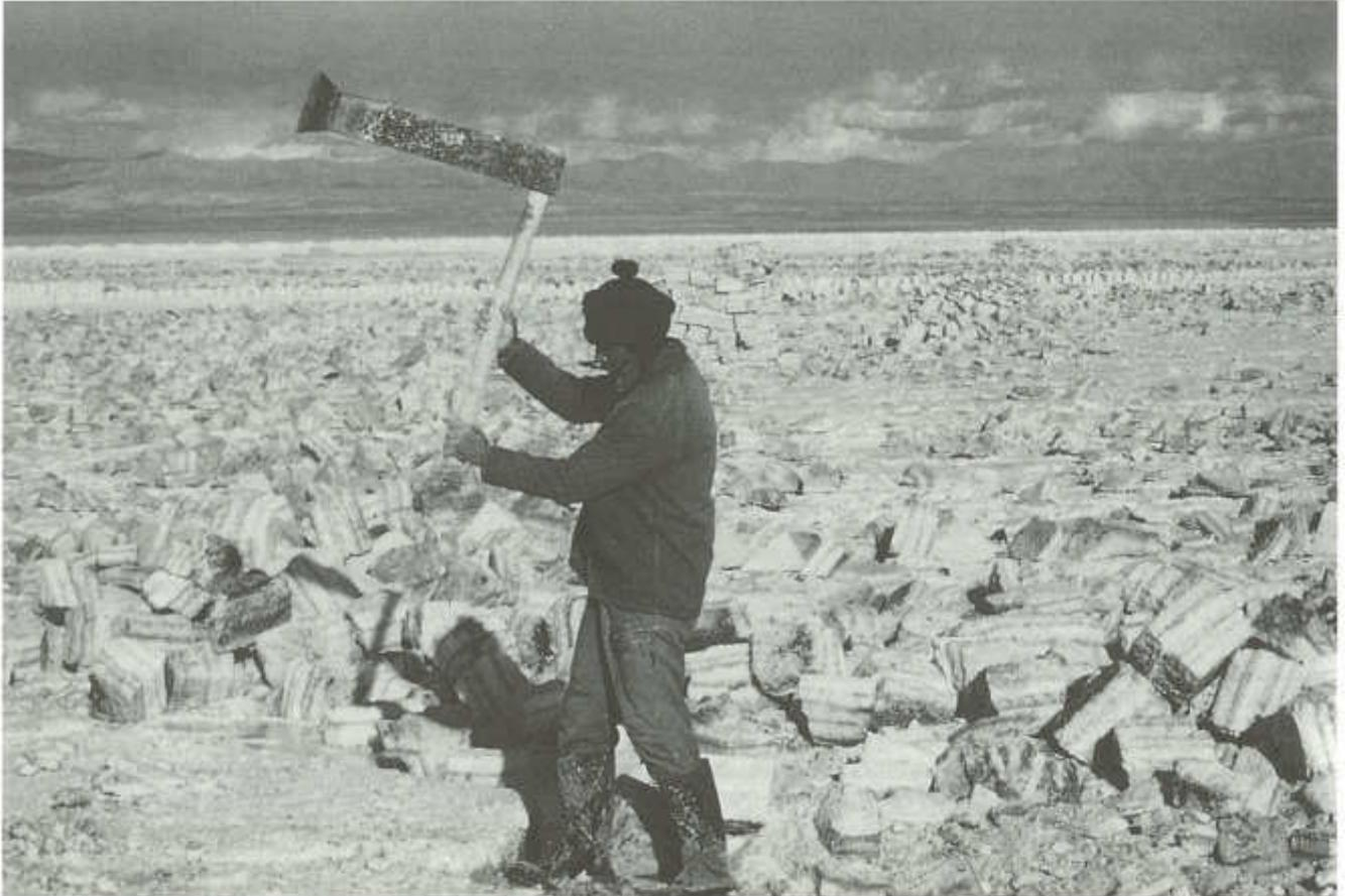
Explotación manual de bloques de sal en un lago de sal. Esta explotación es posible solamente durante el tiempo seco debido a las condiciones climáticas del salar boliviano de Uyuni, ya que la superficie de la sal durante seis meses se encuentra periódicamente bajo agua. Colchani, Potosí, Bolivia
