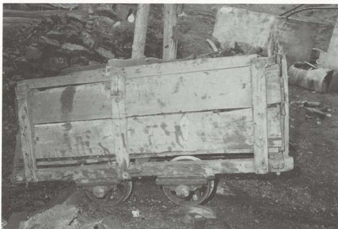
Vagón de madera con compuerta frontal. Instalación de volteo en superficie que facilita el vaciado del vagón. Se ven las elevaciones en forma redonda de las rieles bajo las ruedas del eje trasero. Minería del carbón en la región del Río Checua, Cundinamarca, Colombia
