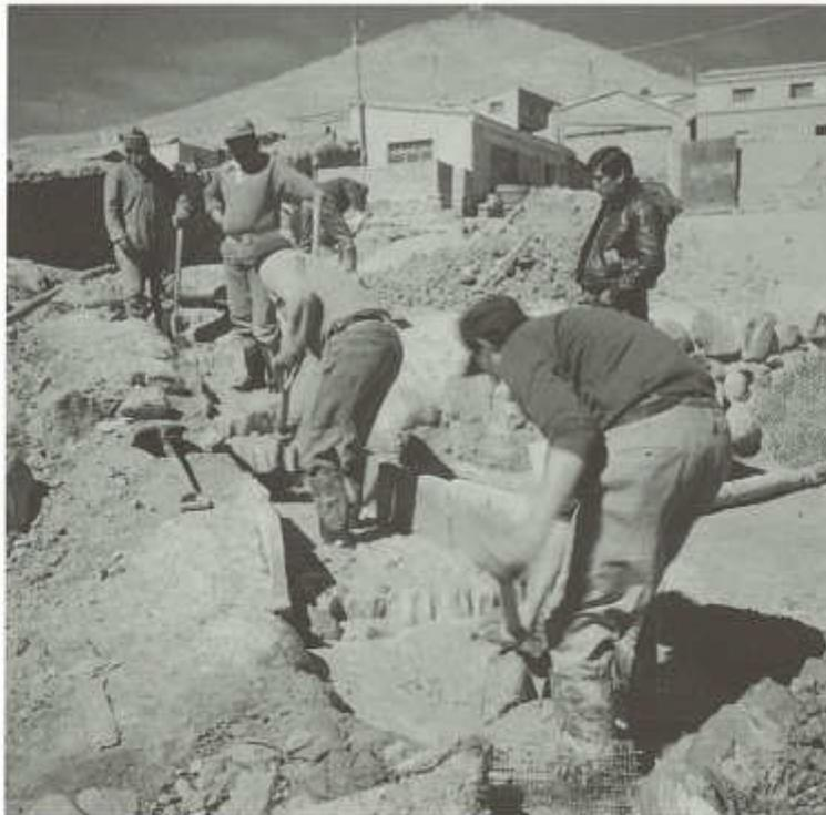
Canaleta de lavado para la clasificación de material de lugares minados de una mina de plomo y plata. Los mineros palean el material constantemente entre las trancas de la canaleta para mejorar la separación y la evacuación del material liviano. Planta de beneficio de la Cooperativa Villa Imperial, Potosí, Bolivia.
