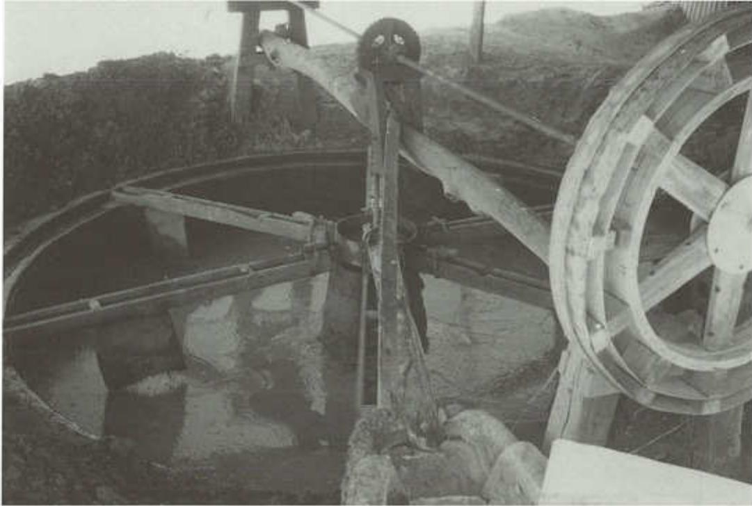
Buddle mecanizado para la concentración de grano de tamaño finísimo de minerales de estaño. Los trapos en la estrella de canaletas sirven para la homogenización del material sedimentado. Planta de beneficio de relaves, Poopó, Oruro, Bolivia
