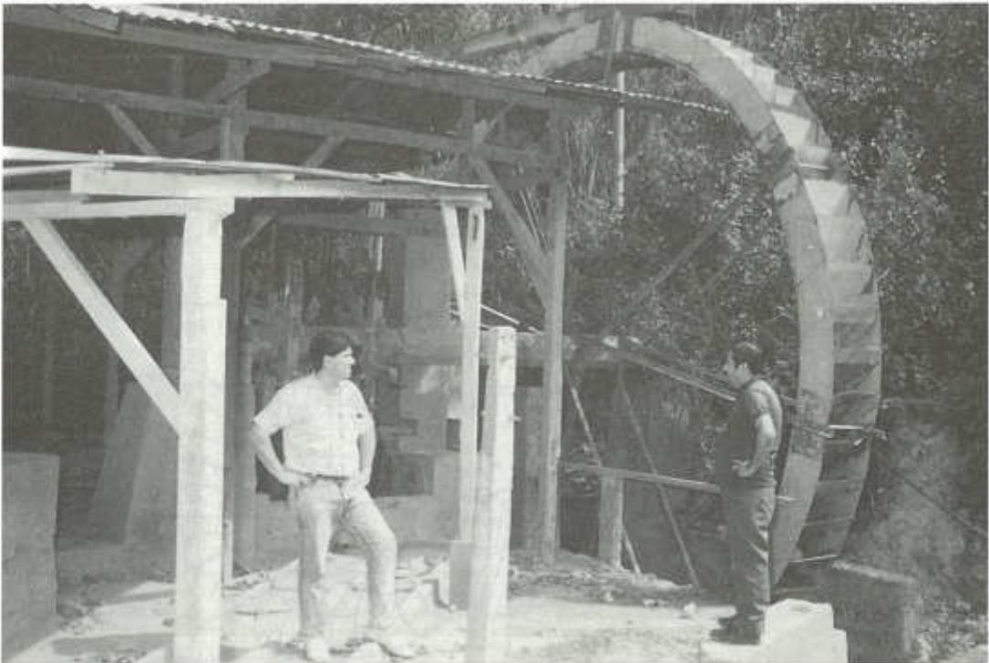
Rueda de agua de hierro de carga superior para el accionamiento de una batería de pisones en Portovelo, El Oro, Ecuador
