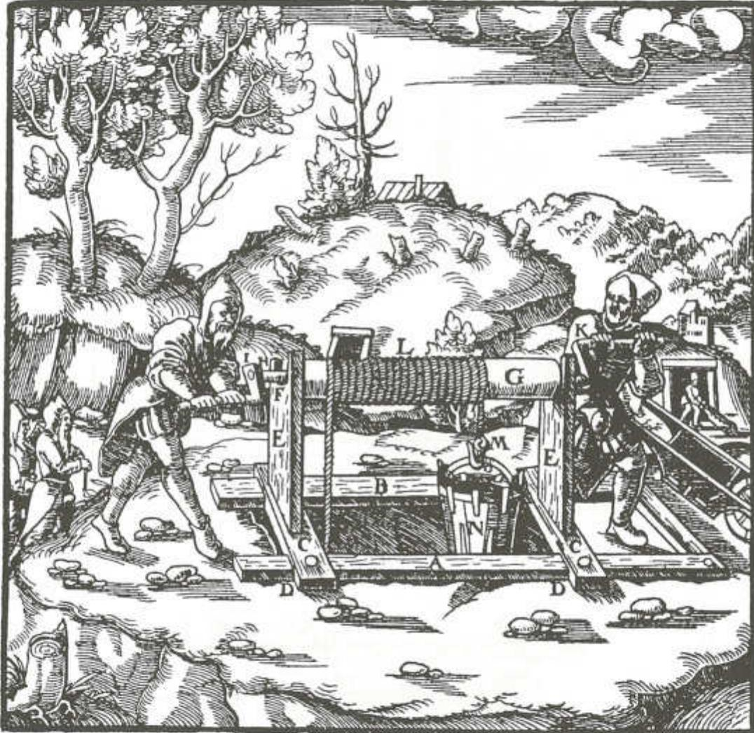
Marco delante del pozo A. Marco detrás del pozo B. Estacas con punta C. Maderas transversales D. Soportes E. Fierros de los postes F. Arbol redondo G. Sus espigas H. Madera I. Manivela K. Cable L. Gancho del cable M. Recipiente N. Su arco O.
