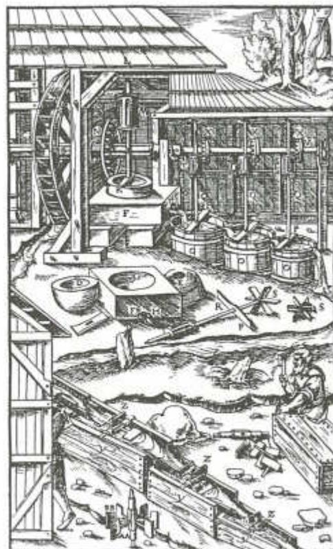
Dib.: Amalgamación en mecanismos de agitación, de Agrícola
