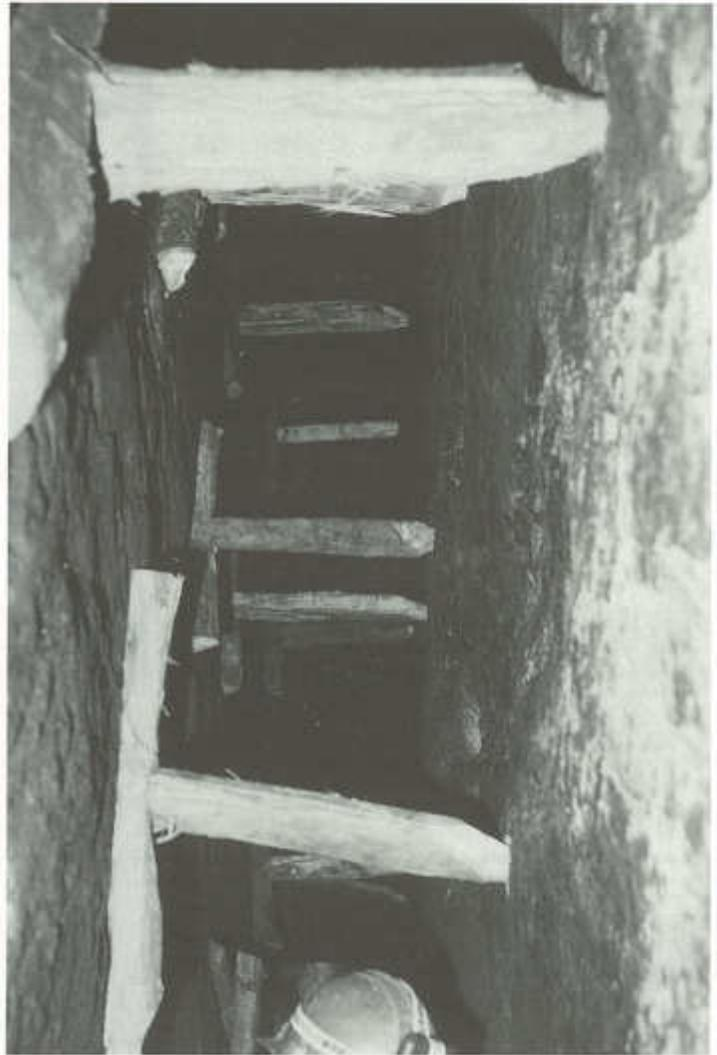
Entibación de madera apuntalada con un sostén en un espacio abierto por el arranque en una pequeña mina de carbón en estratificación empinada. Región del Río Checua, Cundinamarca, Colombia.
