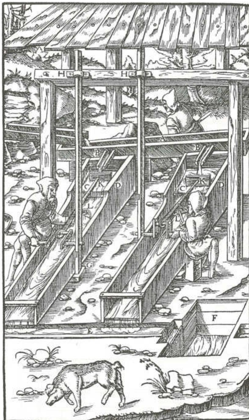
A. Canaleta transversal superior B. Salidas C. Superficie de la mesa D. Cajones de la mesa E. Canaleta transversal inferior
