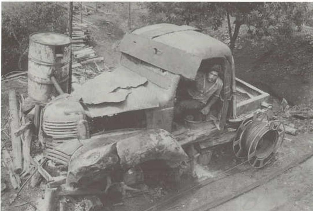
Chasis de camión para extracción en pozo inclinado. A la izquierda del cuadro el turril que sirve para la refrigeración. Minería del carbón en la región del Río Checua, Cundinamarca, Colombia.
