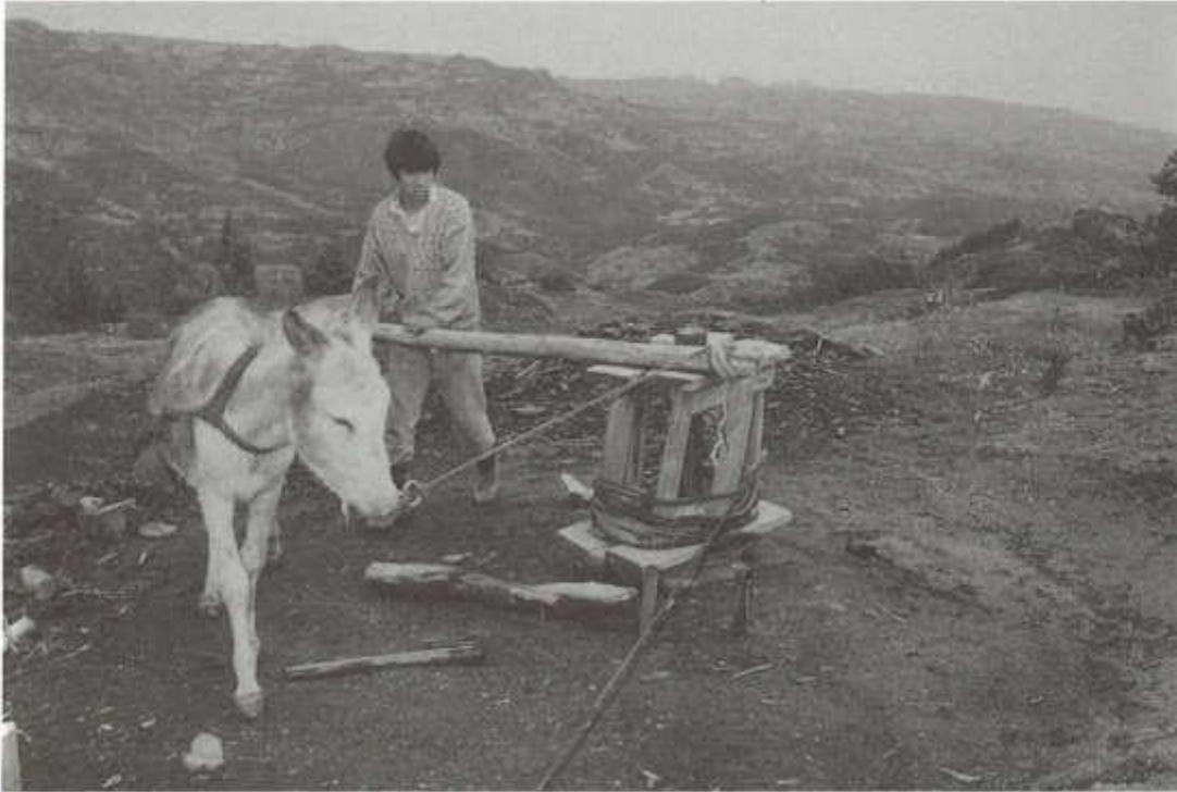
Malacate accionado con un asno, con sogas de cáñamo en operación en una pequeña mina de carbón en la región del Río Checuá.
