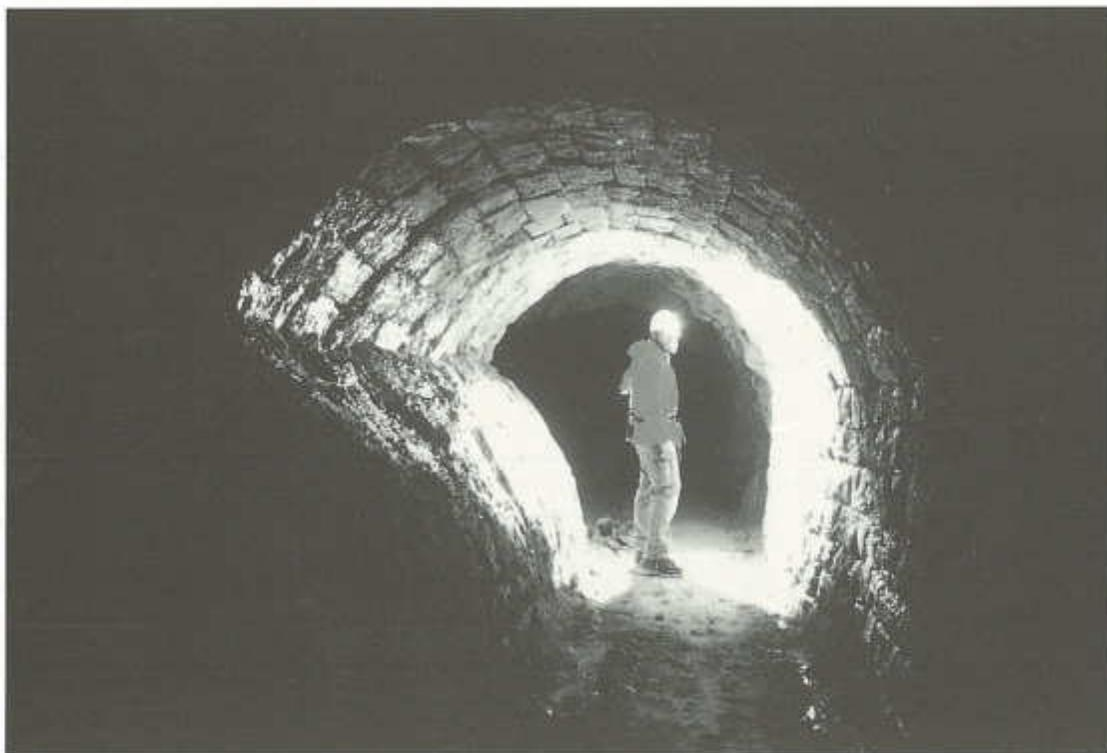
Canal de ventilación embovedado (huayrachina) para la ventilación de una explotación por socavón realizada a través de una fortificación en arco seco de piedra. Mina de plomo-plata-estaño. Mina Candelaria, Sud Lípez, Bolivia.
