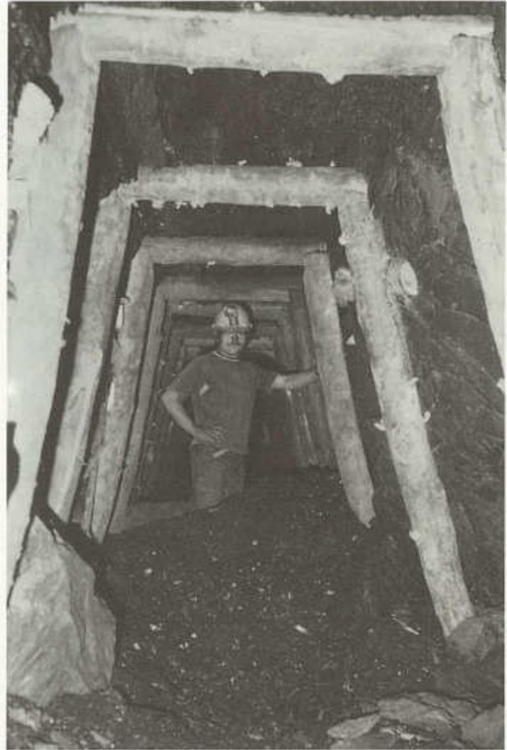
Portada sin revestimiento en un piso de estratificación empinada. Minería del carbón en la región del Rio Checua, Cundinamarca, Colombia
