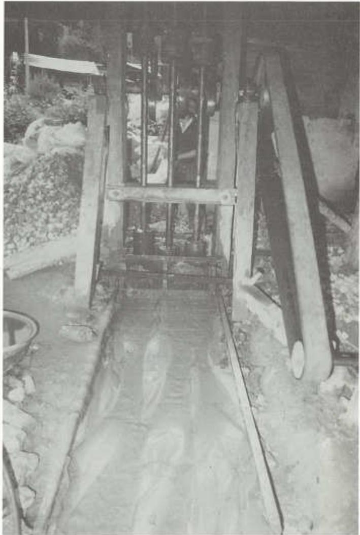
Batería de pisones de hierro con engranaje de transmisión a correa de un motor diesel. En el dispositivo de evacuación de la batería de pisones la cubrejunta de goma agujereada como tamiz evacuador. En primer plano, mesa de lona para la concentración de oro. La Llanada, Nariño, Colombia.
