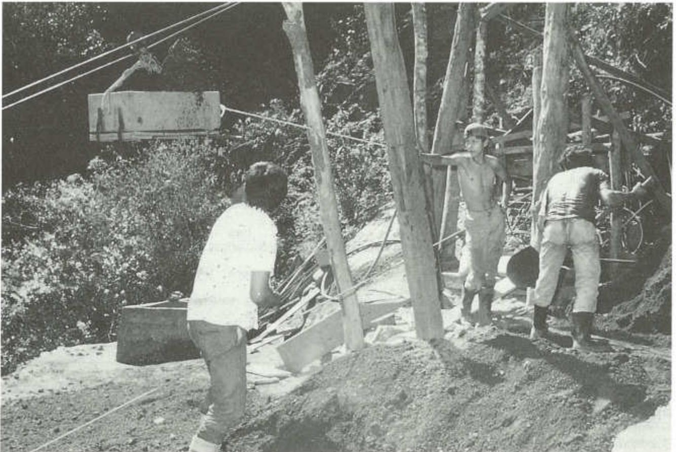
Andarivel simple por gravedad. Lugar de carga en la parte superior cerca de la bocamina durante la carga de un recipiente. A la derecha, el minero encargado de frenar delante de la polea de retorno para el cable de tracción y del tambor para el frenado. A la izquierda, el recipiente cuyo piso se abre automáticamente al pasar por una palanca de tiro. Operación aurífera en la Mina Los Guavos, Sotomayor, Colombia.
